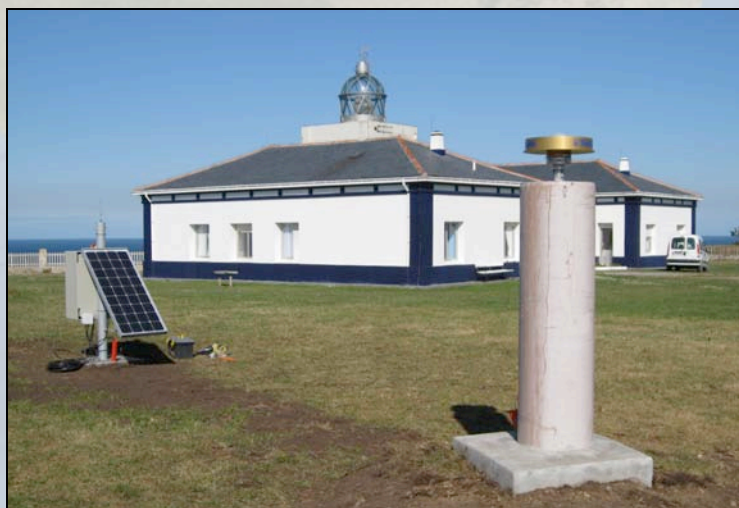
Estación GPS instalada en el Faro del Cabo Busto (Asturias) dentro del proyecto Topo-Iberia compuesta por una antena montada sobre un pilar de hormigón, armario de instrumentos y placas solares.
